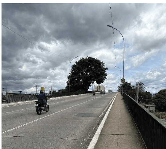
Figuras 19 e 20 – Estruturas com falta de barreiras rígidas para proteção do pedestre Fonte – Comitê de Fiscalização de Pontes e Viadutos, 2026
