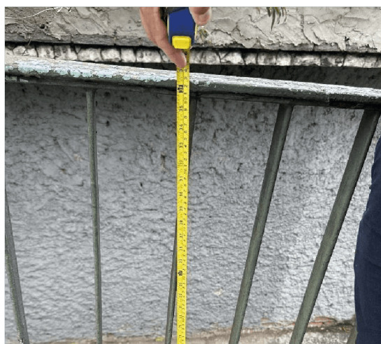
Figuras 19 e 20 – Estruturas com falta de barreiras rígidas para proteção do pedestre Fonte – Comitê de Fiscalização de Pontes e Viadutos, 2026
