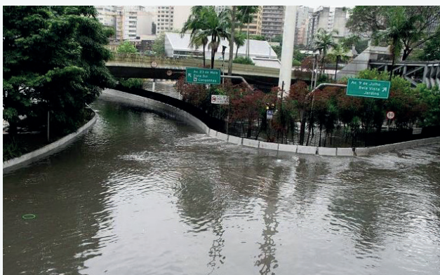
Fonte: Eng. Civ. Hassan Mohamad Barakat Figura: Alagamento na Praça das Bandeiras – SP
