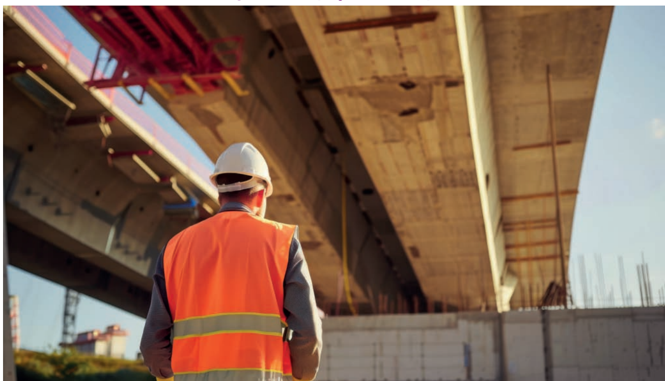
Figura 4 - Inspeção em campo.
