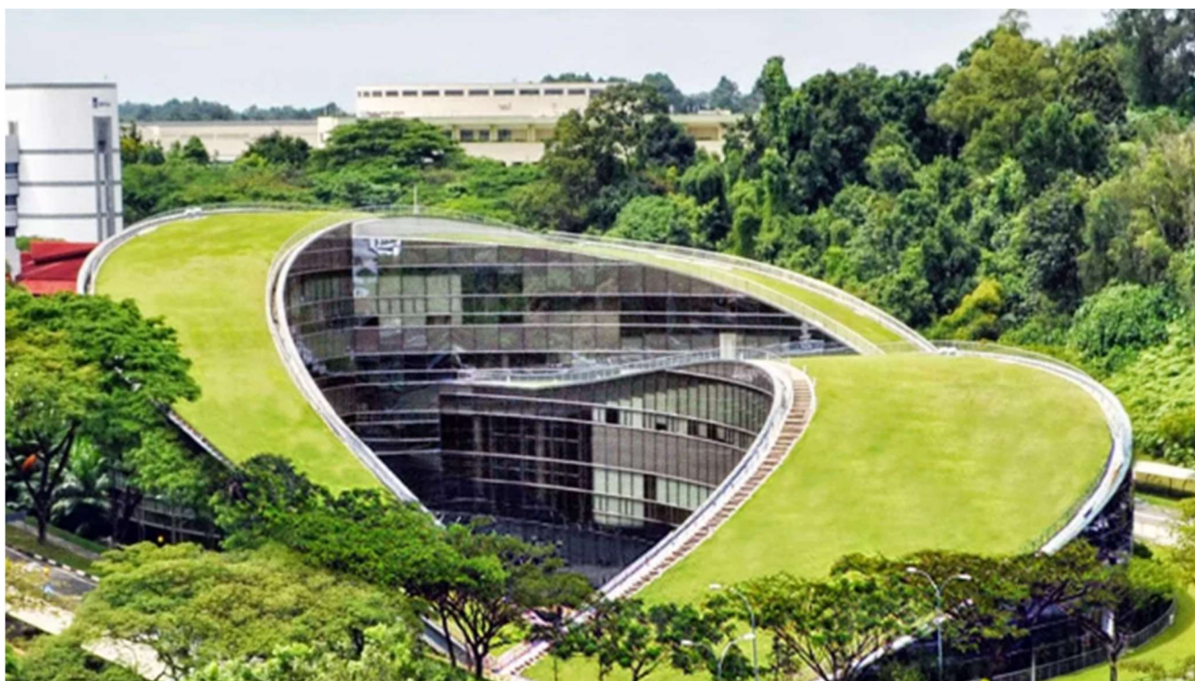
Figura 20. Uso de cobertura verde na Nanyang Technological University (NTU) em Aligarh, Singapura.
