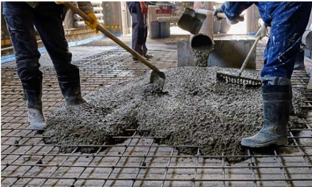
Figura 12. Laje sendo concretada com concreto reciclado.
