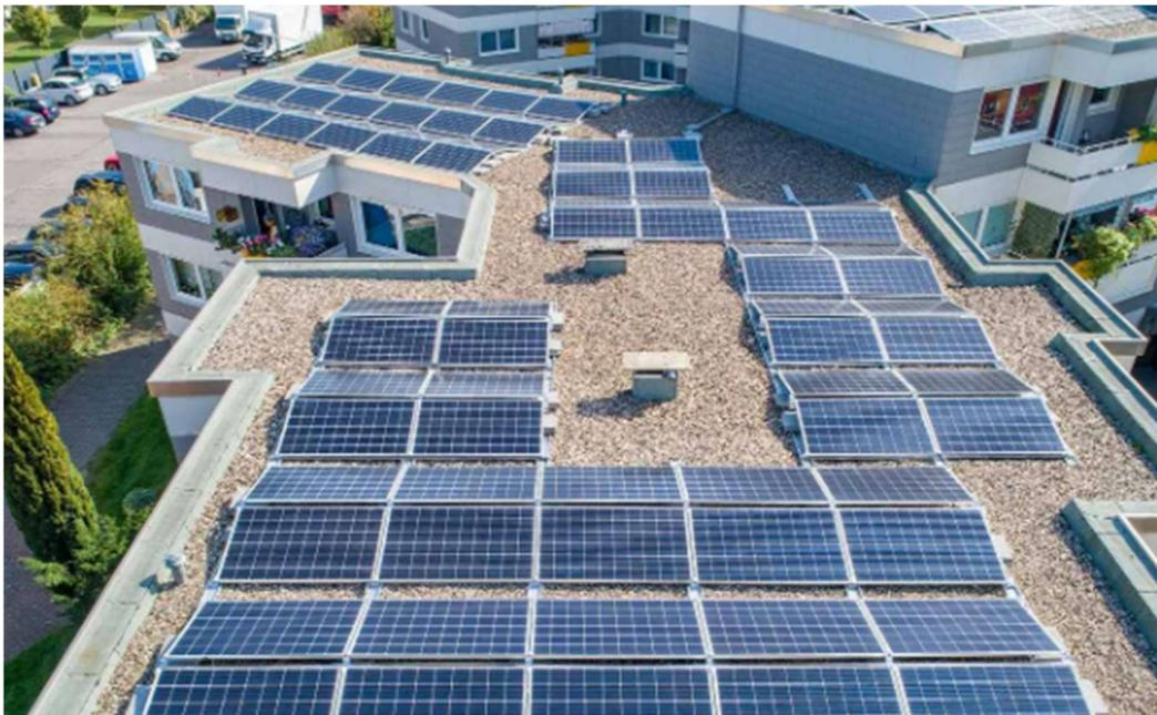
Figura 17. Painéis fotovoltaicos instaladas na cobertura de um prédio.
