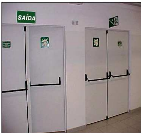
Figura 1: Porta corta-fogo com barra anti-pânico
