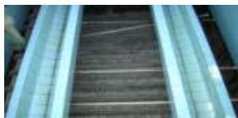
Figura Nº 7. Filtro Nº 6, com tela termoplástica.
