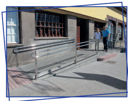
Rampa para acessibilidade, com todos os dispositivos: piso tátil, tátil alerta, corrimãos de duas alturas e tátil em Braille.
