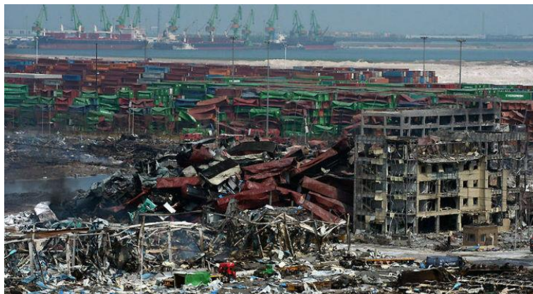
Figura 8 – Explosão e incêndio em terminais de produtos químicos e inflamáveis (Tianjin – China).
