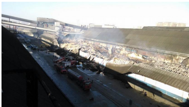
Figura 3 – Incêndio em terminal açucareiro (Santos – SP).
