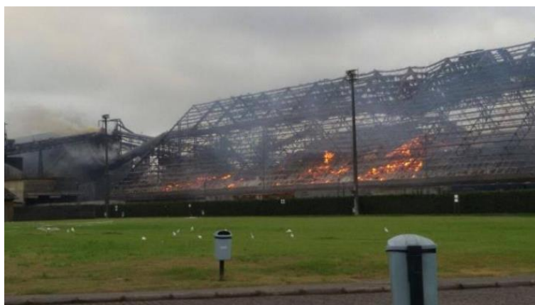
Figura 5 – Incêndio em terminal açucareiro (Guarujá – SP).
