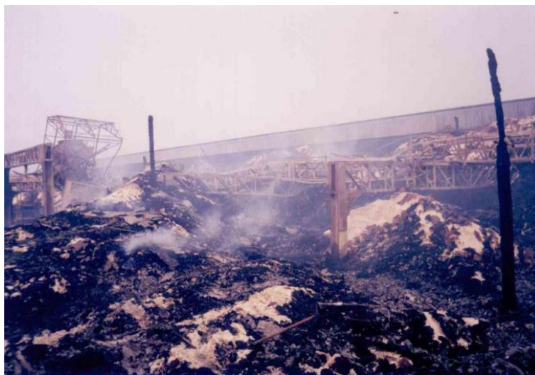
Figura 8 – Incêndio em armazém açucareiro (Santos – SP).
